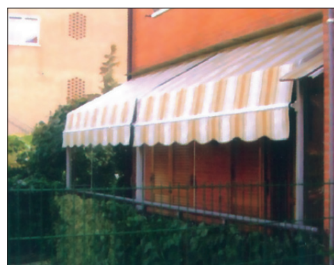
Tenda scorrevole su guide laterali adatta per le coperture di piccole superfici
